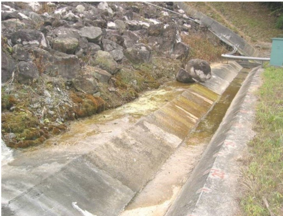
(d) On-site water leakage phenomenon 2.
